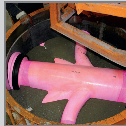
Afb. 5: Vervolgens worden de bekistingen naar het vulstation gebracht. Hier wordt de bekisting met beton gevuld.
