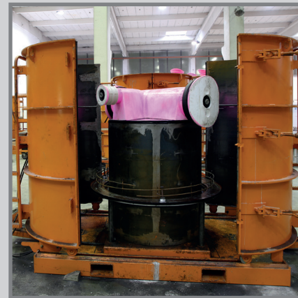
Afb. 4: De mal wordt in de bekistingsolie gezet en in de stalen bekisting geplaatst.
