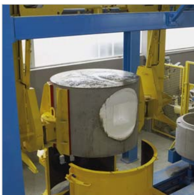
Afb.7: Met behulp van speciaal geconstrueerde klemmen wordt de put gedraaid en ondersteboven gezet.
