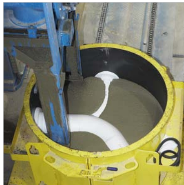
Afb. 5: Vervolgens worden de bekistingen naar het vulstation gebracht. Hier wordt de bekisting met zelfverdichtende beton gevuld.
