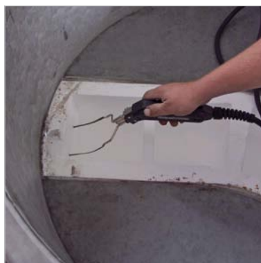
Afb.8: De verwarmingsdraad snijdt holle ruimtes in het piepschuim, dat vervolgens heel gemakkelijk kan worden verwijderd.
